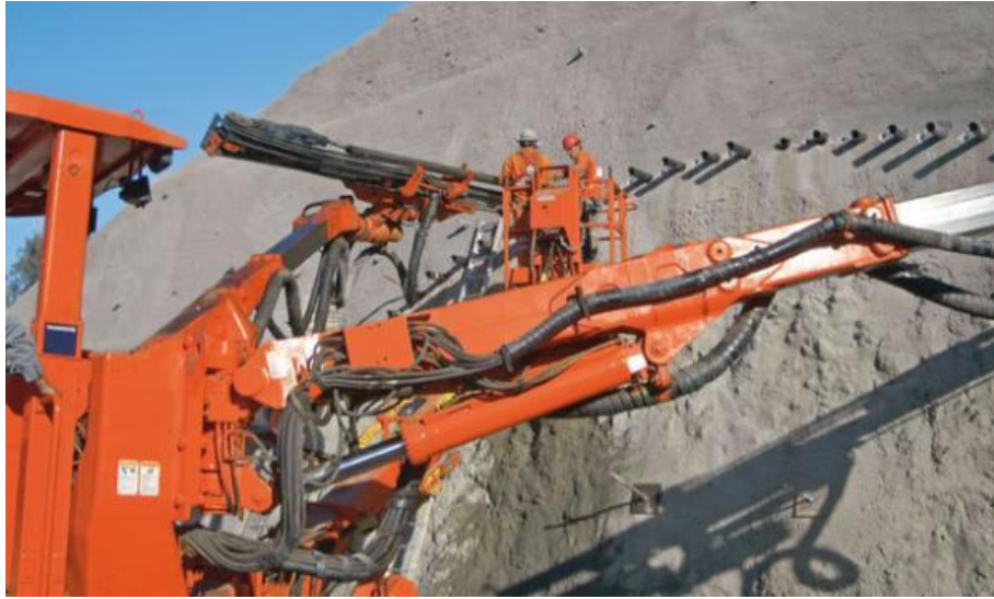
Tunnel - renforcement du front de taille et consolidation des parois
