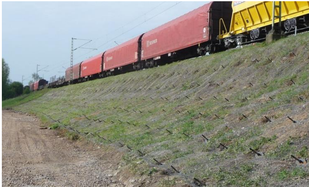
Stabilisation de talus – ouvrages linéaires
