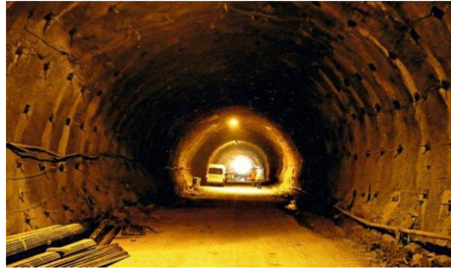
Tunnel - renforcement du front de taille et consolidation des parois
