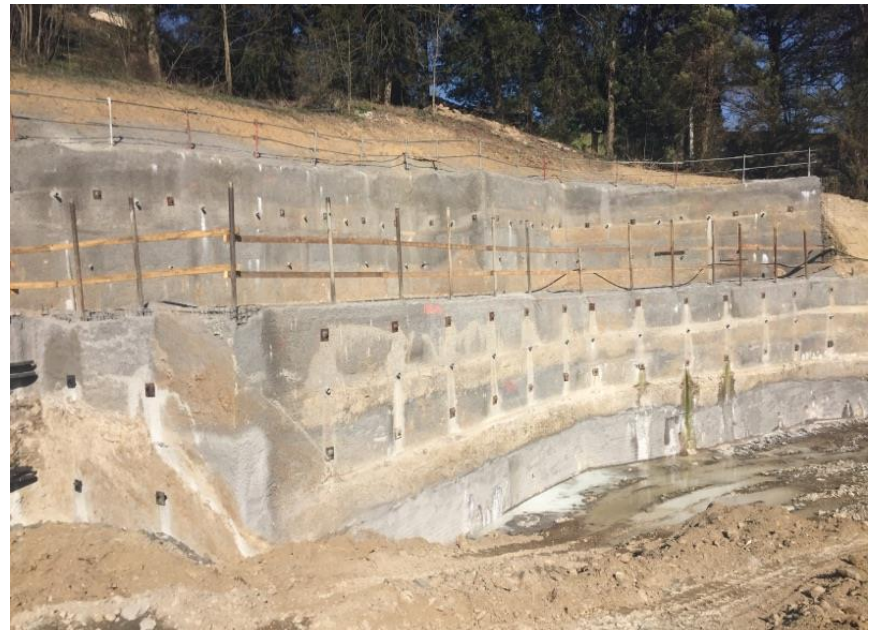
Paroi en béton projeté
